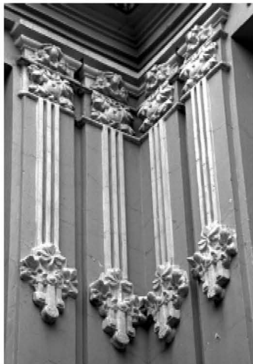
Destalles de la decoración de las columnas.
